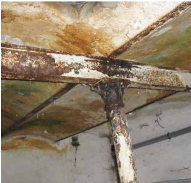
Stropy w wielu miejscach były uszkodzone.
